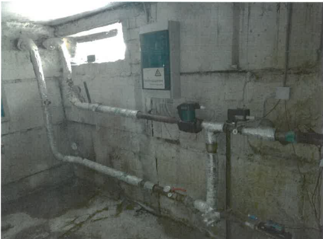
6 pav. Pastebimas drėgmės poveikis rūšio konstrukcijoms.
