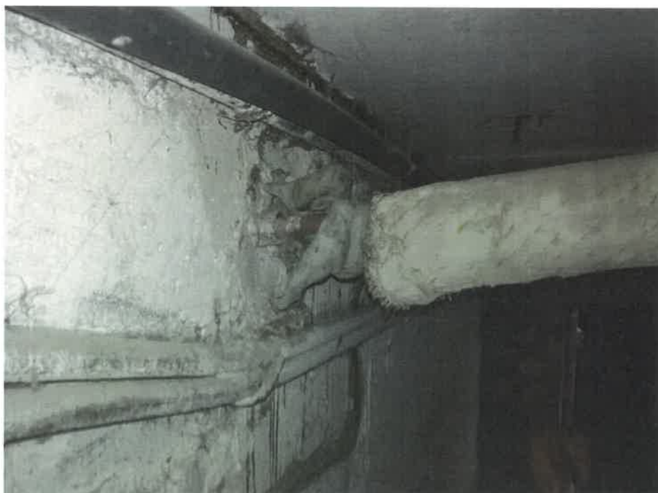
8pav. Netinkamas vamzdžių šiltinimas rūsyje.
