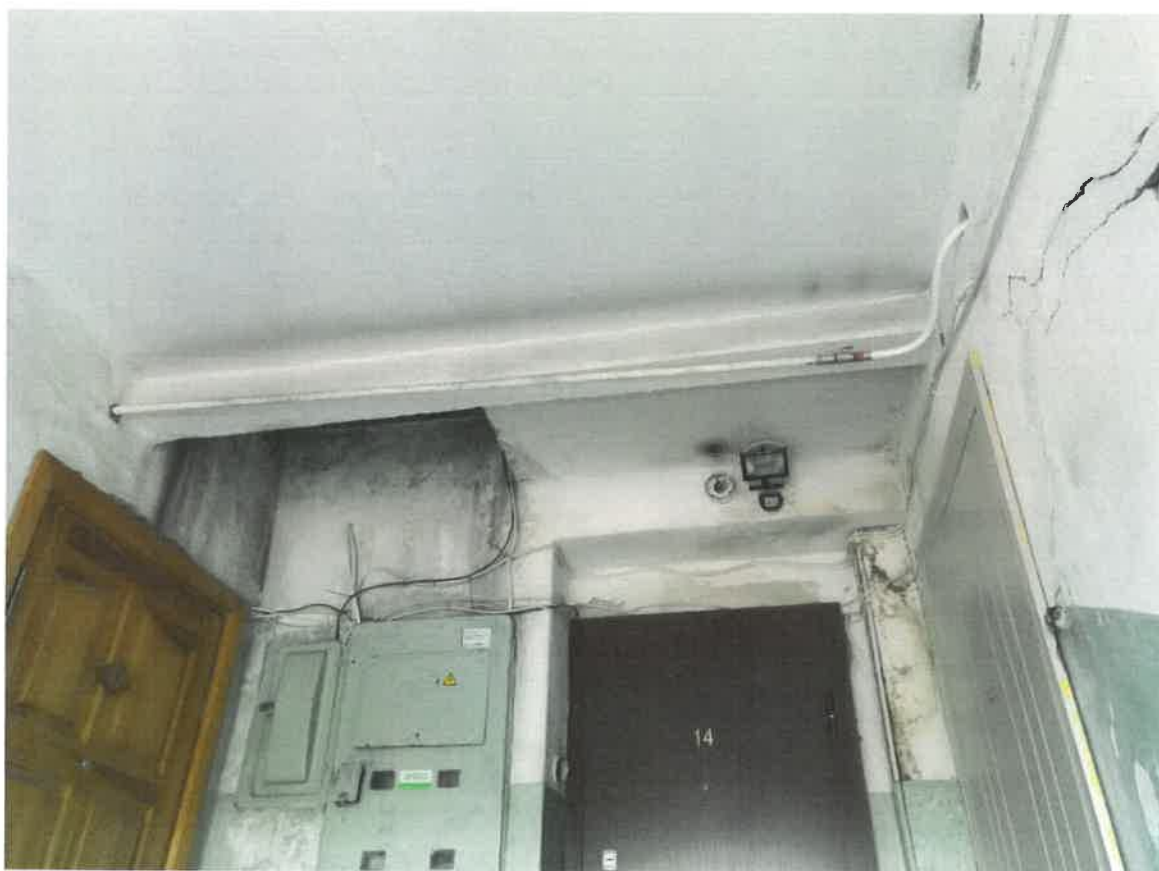
12 pav. Liptinės sienos suskilinėjusios, paveiktos drėgmės.
