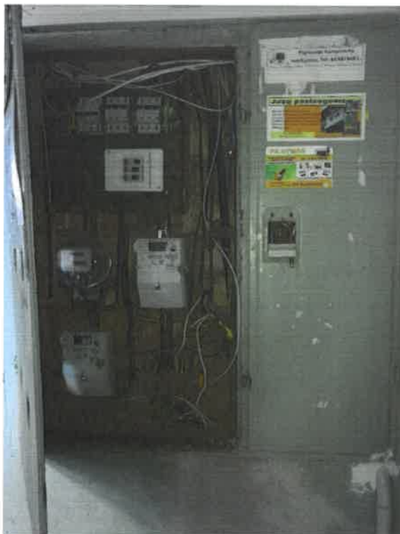
9 pav. Elektros paskirstymo skydai laiptinėje.
